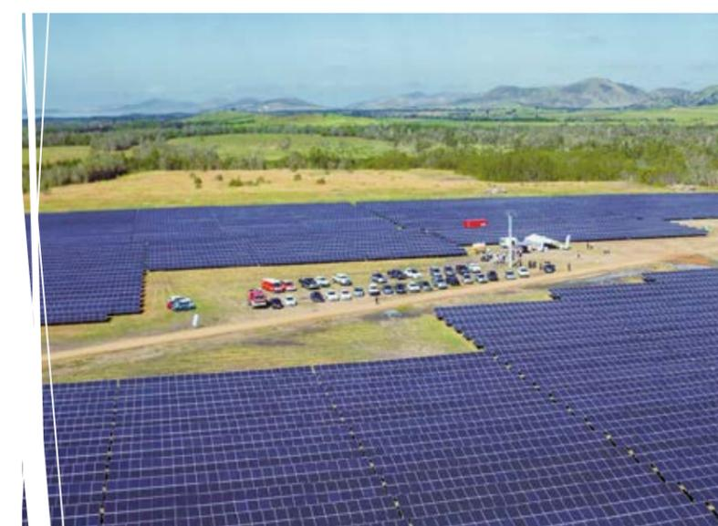
Hélio Boulouparis : 43 200 panneaux pour une puissance de 11 MW.
