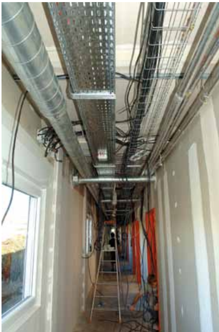
La fibre optique équipe l'ensemble du Médipôle pour une meilleure performance des systèmes de télécommunication.
